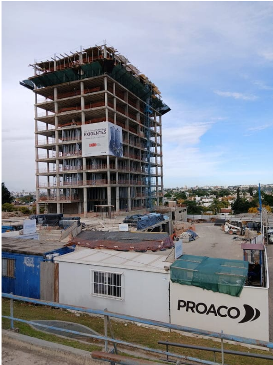
Una de las torres que construye Salim en barrio Villa Cabrera.
