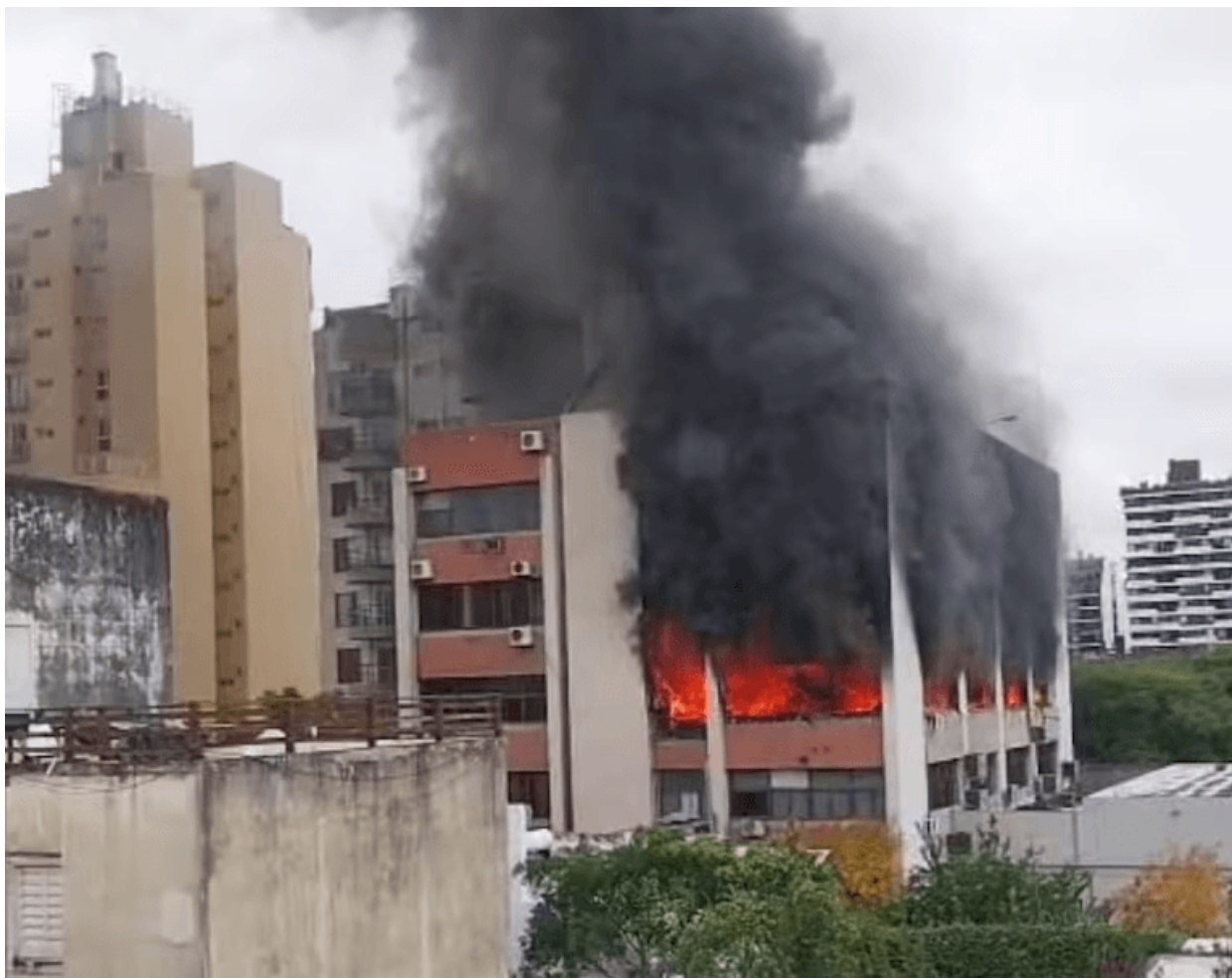
Incendio sede del APROSS 18/4/2024
