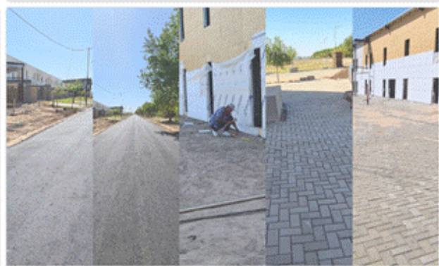
PAVIMENTO Y ADOQUINADO COMPLEJO NORTE RIO SEGUNDO.
