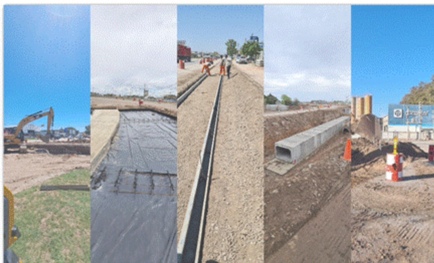
DUPLICACION DE CALZADA Y ROTONDAS RUTA NACIONAL 9
