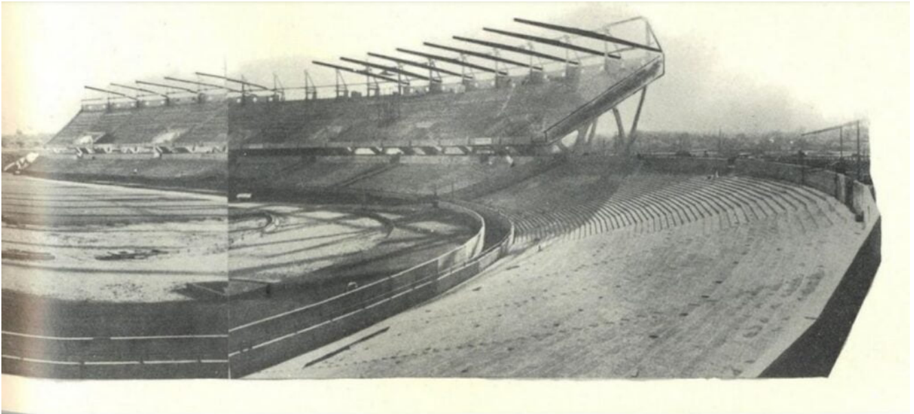
Obras del Estadio Olímpico. Archivos del Estado Nacional.
