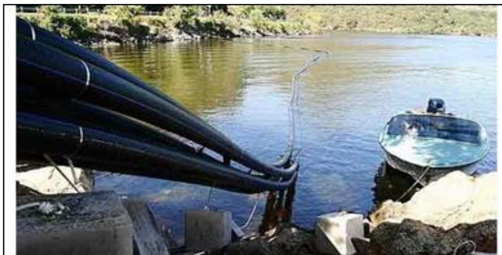
Obras de aireación del lago de Roggio Electroingeniería
