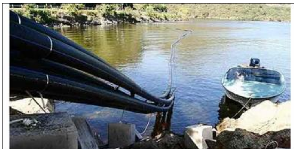
Obras de aireación del lago de Roggio Electroingeniería
