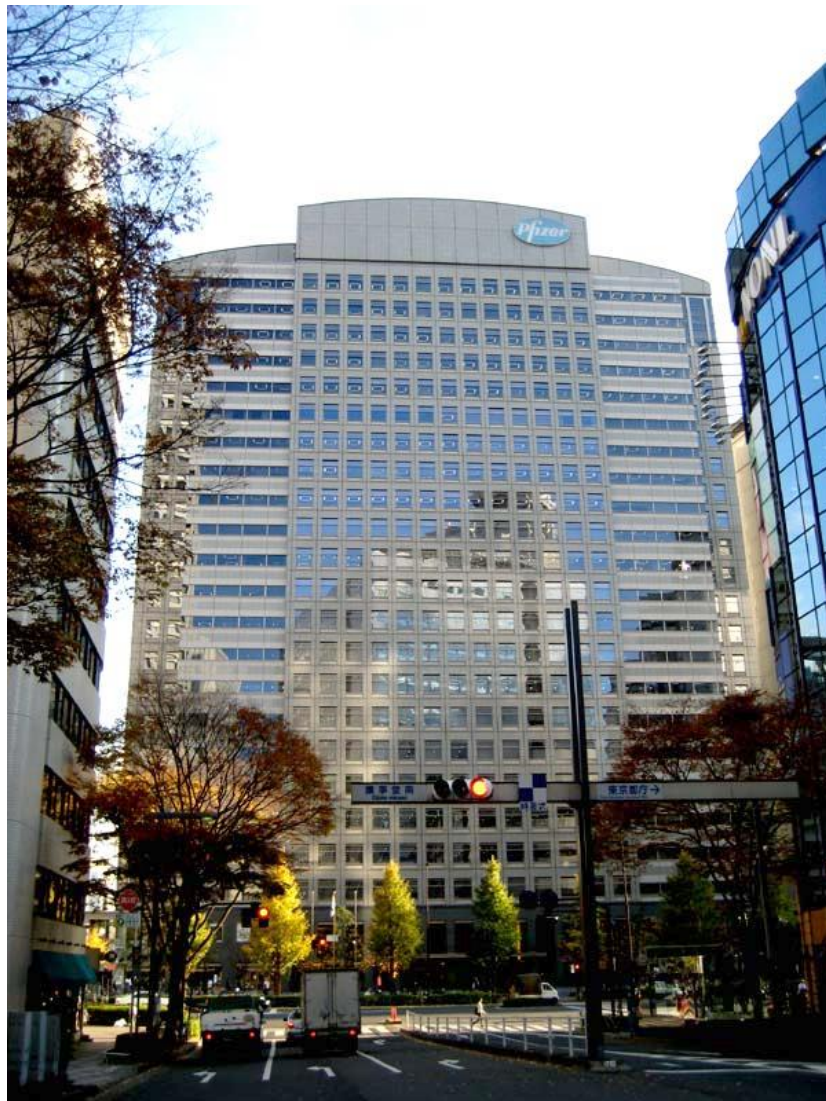
Edificio del laboratorio Pfizer en Estados Unidos
