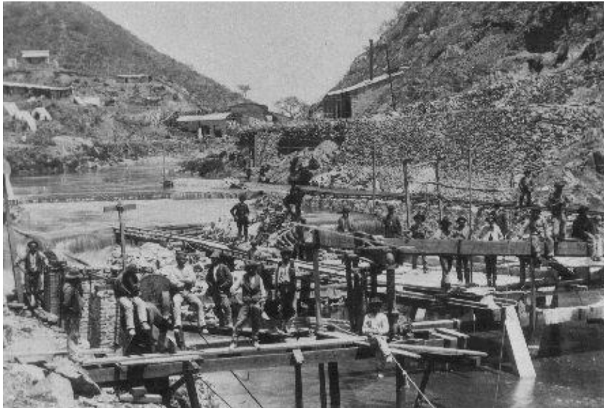
Obreros en orillas del Río Primero comenzando los cimientos del Antiguo Dique San Roque
