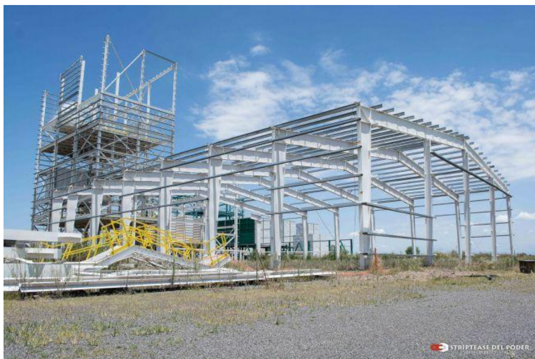
Fábrica de Monsanto en Malvinas Argentinas a medio terminar
